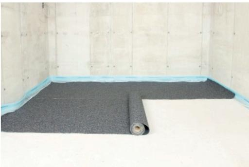
2. SPEBA® DAMTEC® estra Dämmunterlage vollflächig und im Raum auslegen und etwas größer zuschneiden. SPEBA® DAMTEC® estra mindestens 24 Stunden entspannen und akklimatisieren lassen.
